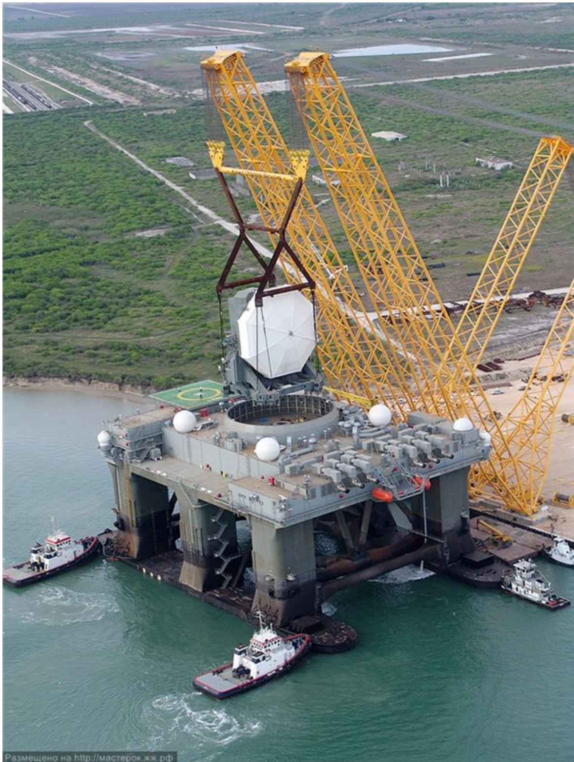
Установка на полупогружную платформу проекта CS50 «Выборгского ССЗ» РЛС системы ПРО США
